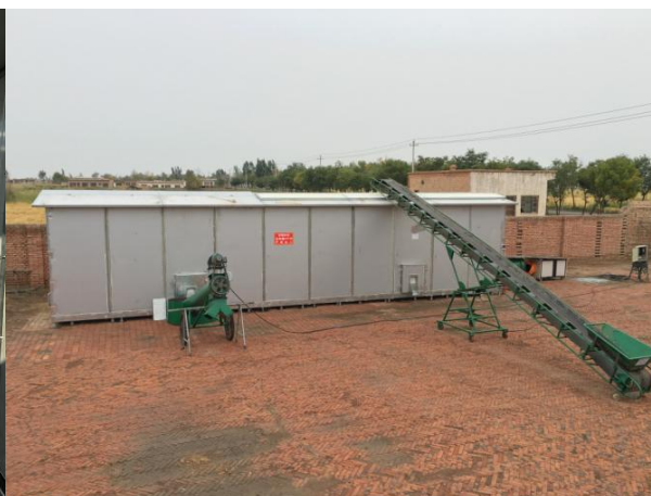
安装调试完毕
