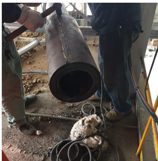
图 7-9 水冷夹套
